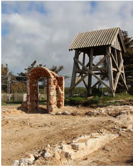
Fig. 6. Portalen af den nedrevne Mårup Kirke, 2015. På trods af havet var ved at æde sig ind på kirken og gjorde en nedbrydning nødvendig, var mange kede af, at dette stykke lokale identitet forsvandt. Foto: Thomas Bertelsen 2015
