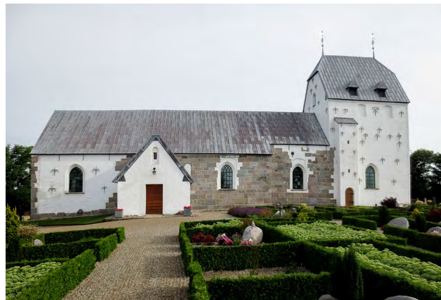
Fig. 4. Kirken i Stepping mellem Kolding og Haderslev fik i senmiddelalderen – ud over sakristi og våbenhus – såvel en vestforlængelse, som en østforlængelse; den sidste i form af et tårn, hvis underdel fik funktion som kor. I sognet har Højrup Kirke ligget, om end den nøjagtige placering er ukendt. En forøgelse af sognet ved nedlæggning af Højrup kan have givet baggrund for Stepping Kirkes udvidelser. Foto: Jakob Kieffer-Olsen
