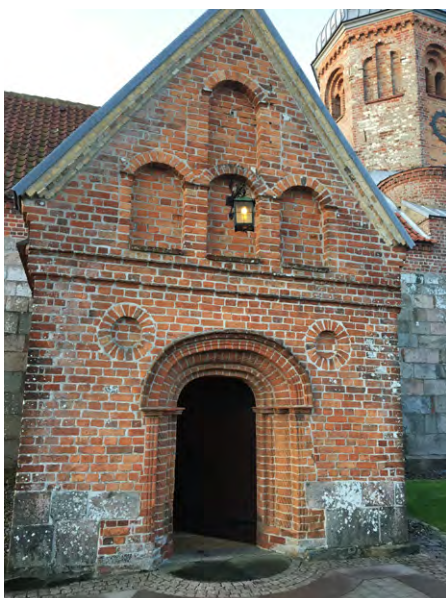
Fig. 10. Astrup Kirke i Himmerland er opført i 1542 af det stedlige herremandspar på gården Villestrup. Den gamle, romanske kirke blev næsten totalt revet ned, og i stedet rejstes en ny af munkesten og med anvendelse af kvadre fra mindst et par nedrevne kirker. Tårnet i vest samt våbenhuset fik svungne buer og dekorative led i en blanding af træk af romansk og renæssance. Foto: Per Kristian Madsen
