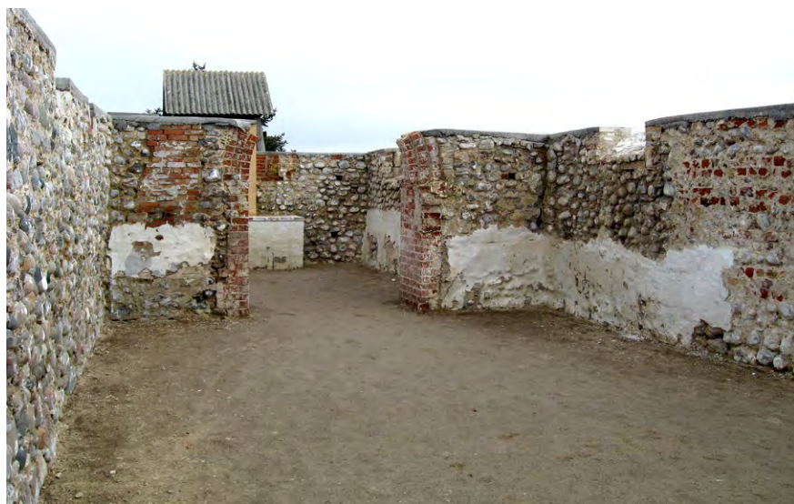
Fig. 4. Mårup Kirke under nedtagning, 2009. Nedtagningen af kirken begyndte i 2008, og blev udført af flere omgange. Nedtagningen og de arkæologiske undersøgelser, den gav mulighed for, blotlagde unik viden om både arbejdsgange, leveforhold, flora og fauna i middelalderen generelt, og i området specifikt. Foto: forfatteren
